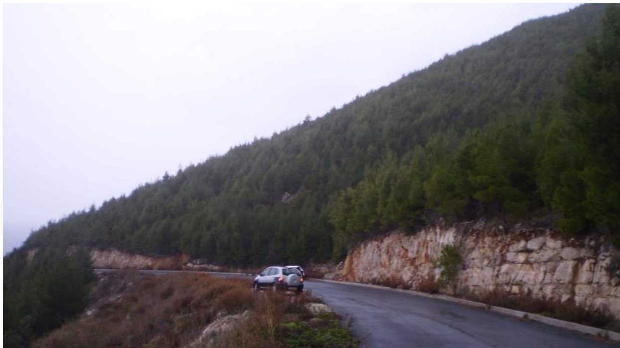
Slika 2.1./5. Područje zahvata – početak trase, spoj novoplanirane i postojeće ceste (Autor: Oleg Grgurević)
